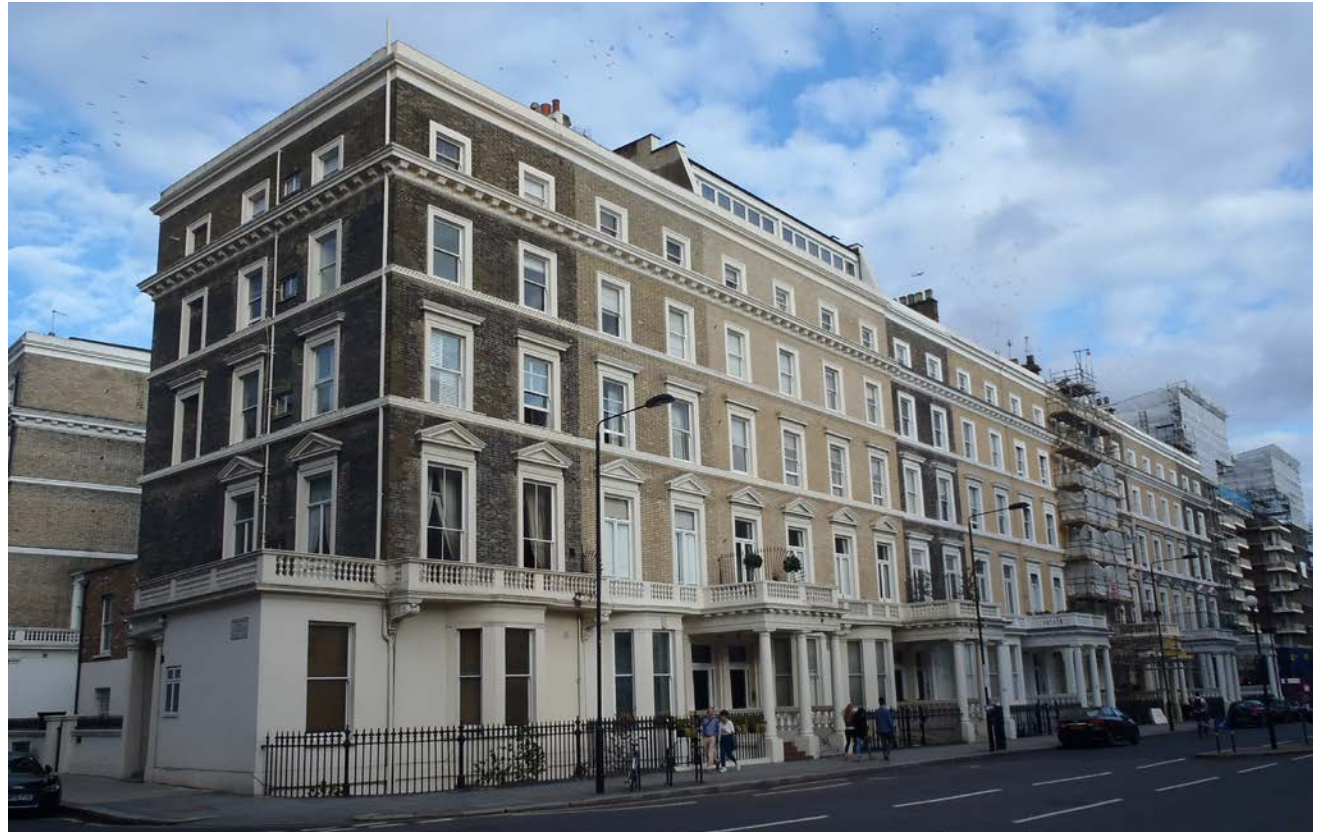
Nos. 37-59 (odd) Gloucester Road
