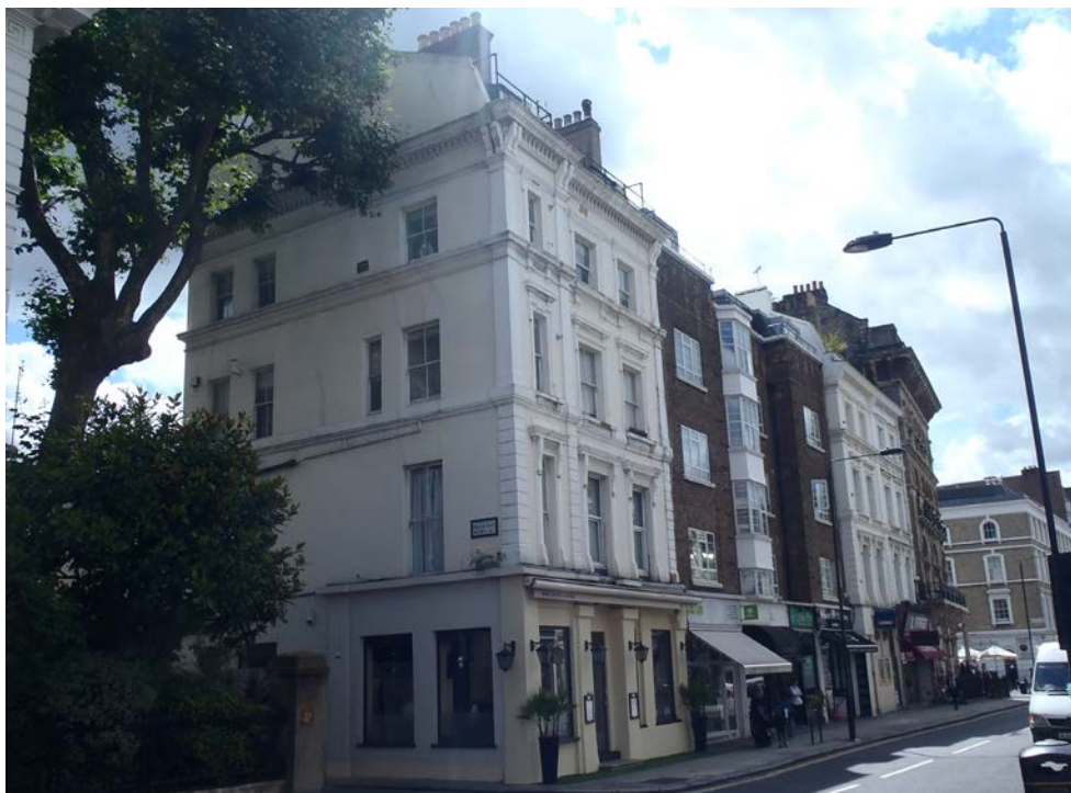
Nos. 1-13 (odd) Gloucester Road
