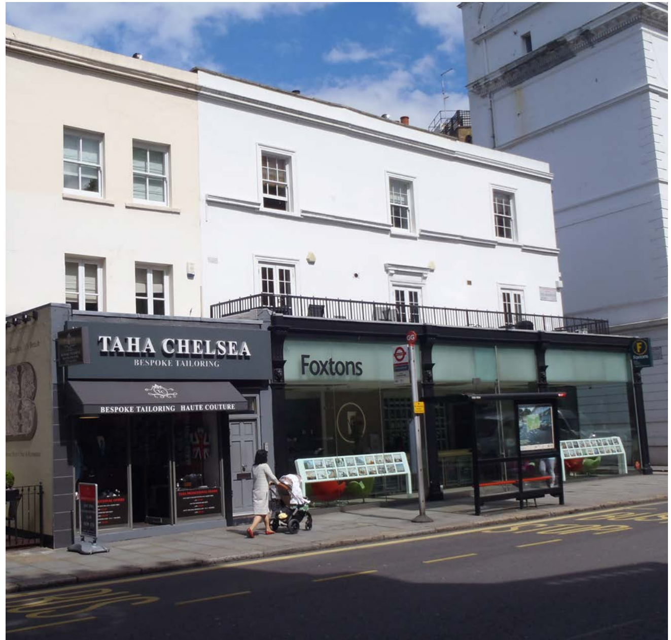
Nos. 94-100 (even) Old Brompton Road
