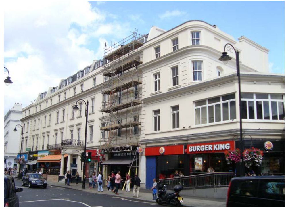
Nos. 71-85 (odd) Gloucester Road
