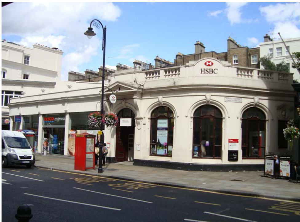
Nos. 87-95 (odd) Gloucester Road
