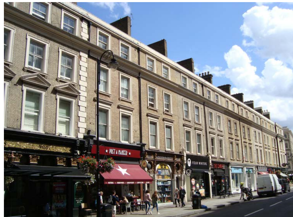
Nos. 97-117 (odd) Gloucester Road
