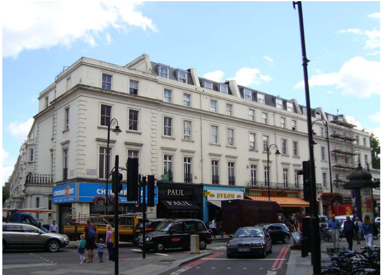
Nos. 71-85 (odd) Gloucester Road
