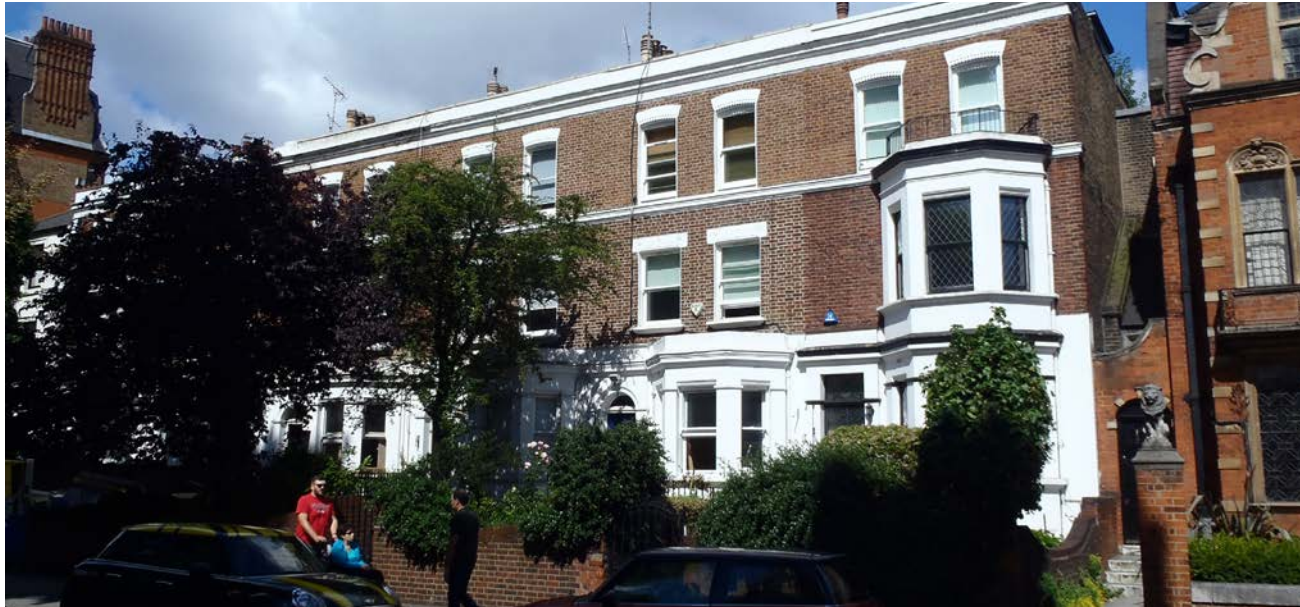
Nos. 108-114 (even) Old Brompton Road
