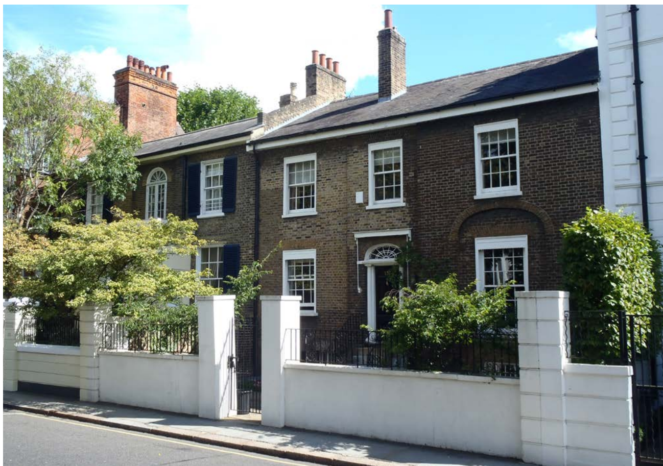
Nos. 135-137 (odd) Gloucester Road
