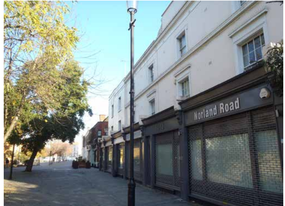
Nos. 14-24 (even) Norland Road
